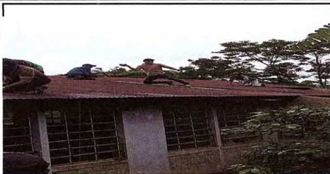
Foto1: Aula 1. MULTIGRADO Sustitucion de estrutura de techo
