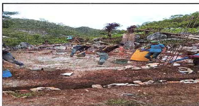
Foto 6: contruccion de cocina
