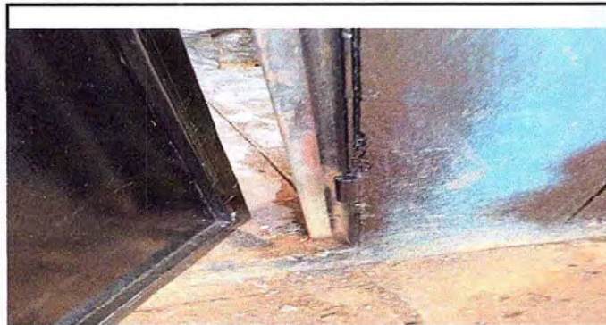
Foto 3: MANTENIMIENTO DE PUERTA
