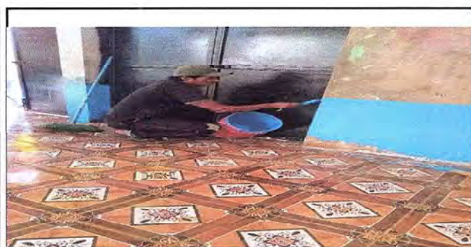
Foto 5: Aula 2. Cambio de pintura lado Interior Y exterior.
